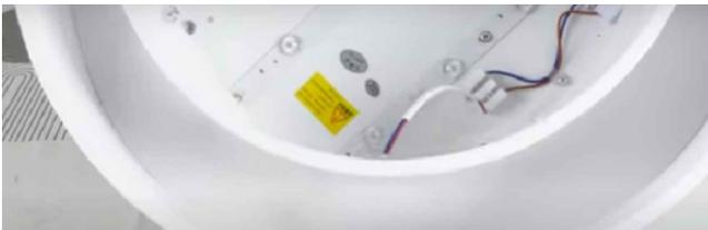
Les fils du circuit domestique sont connectés aux fils des lampes au moyen des bornes de connexion.
